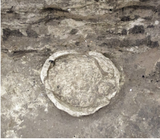
Şekil 4 Bina 162'nin doğu duvarına yerleştirilen küçük sıvalı çöp kutusunun doğuya bakan fotoğrafı (F.8184).
