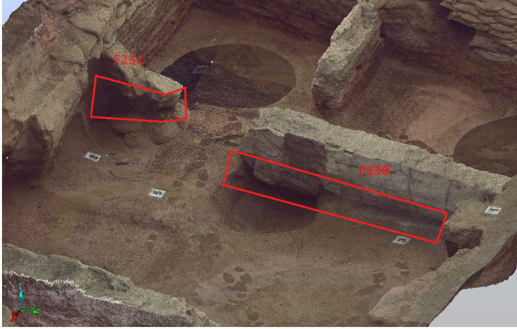
Şekil 39. F.230 ve F.231 nolu duvarda erozyon dolayısıyla gözlenen oyulma
