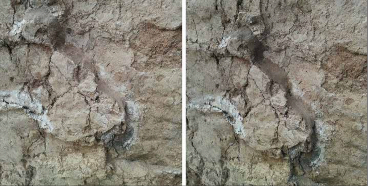
Şekil 31. B.132 duvarındaki katmanlarına ayrılan sıvaya uygulanmış kireç/perlit uygulaması. Bir saat içinde gerçekleşen renk değişimi ise sağ taraftaki resimde verilmiştir.
